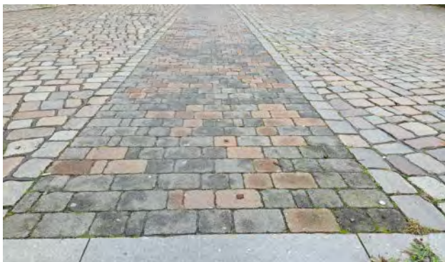
Abbildung 35: Beispiel Anpassung Kopfsteinpflaster (Eigene Aufnahme)
